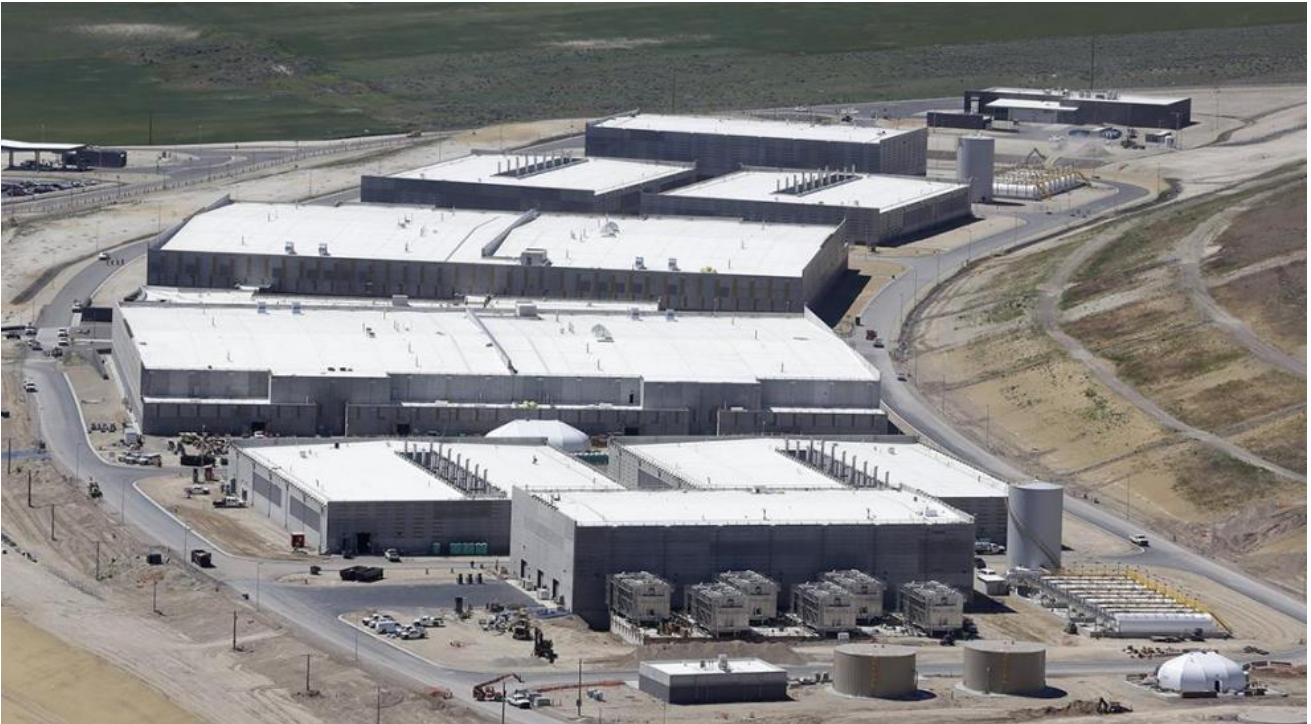
Bild 2: NSA-Datenzentrum in Bluffdale, USA (Quelle: businessinsider.com )
