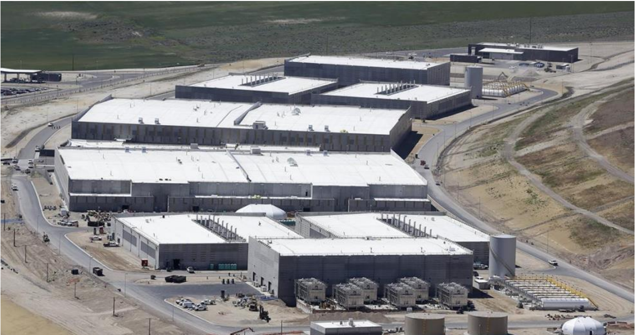
Bild 2: NSA-Datenzentrum in Bluffdale, USA (Quelle: businessinsider.com )
